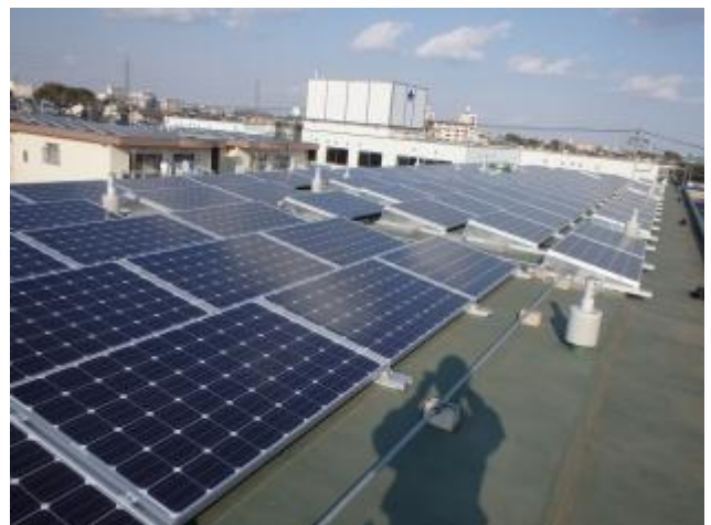
深大寺市営住宅 A 棟
