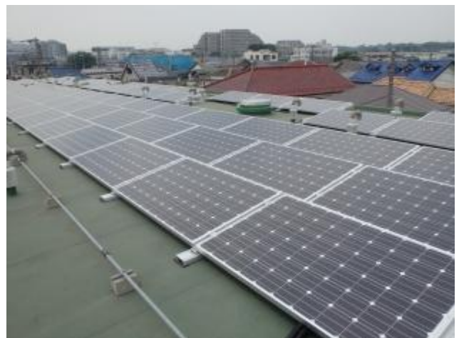
八雲台市営住宅B棟
