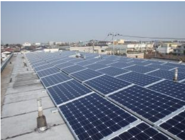
下石原市営住宅A棟
