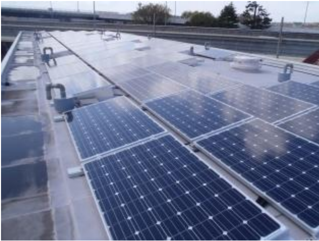
富士見第2市営住宅D棟
