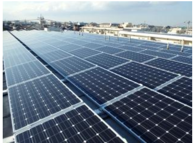
下石原市営住宅B棟
