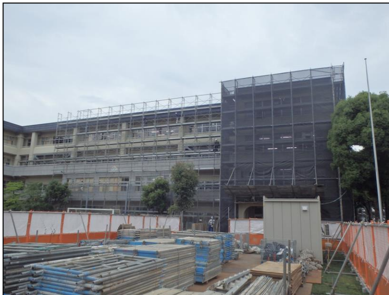
No.4 調布市立深大寺小学校校舎外壁改修工事 外部足場 設置状況
