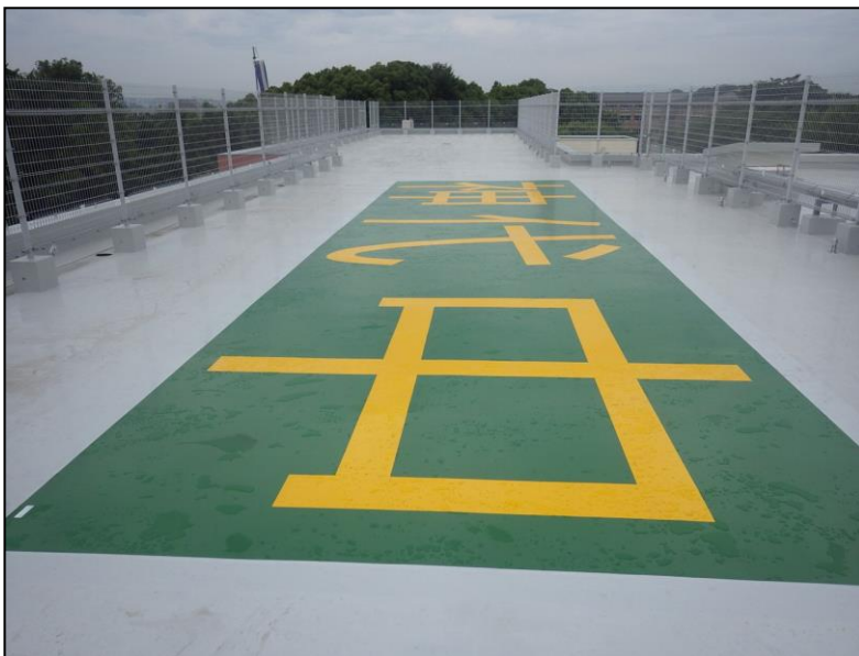
No.3 神代中学校北校舎屋上防水ほか改修工事 屋上防水 施行状況 ヘリサイン設置完了
