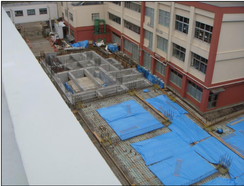
No.1 調布市立神代中学校校舎増築工事 増築箇所 全景
