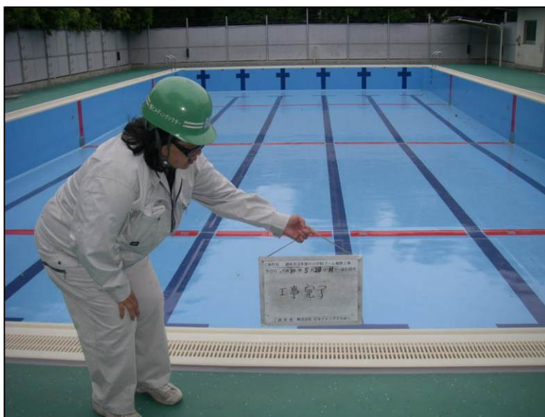
No.6 調布市立多摩川小学校プール補修工事 プール水槽補修作業 完了状況
